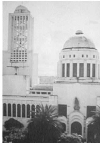
Nueva Catedral de Ambato construida luego del Terremot de 1949
