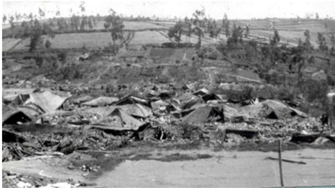
Pelileo: Epicentro del Terremoto, totalmente destruída, como se puede apreciar no quedó una sola casa en pie. 1949.
